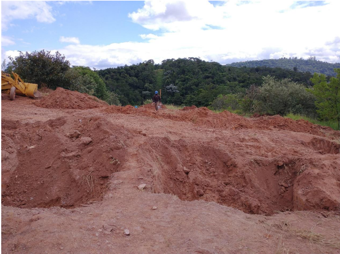
Vista geral das escavações realizadas na Faixa de Dutos.
