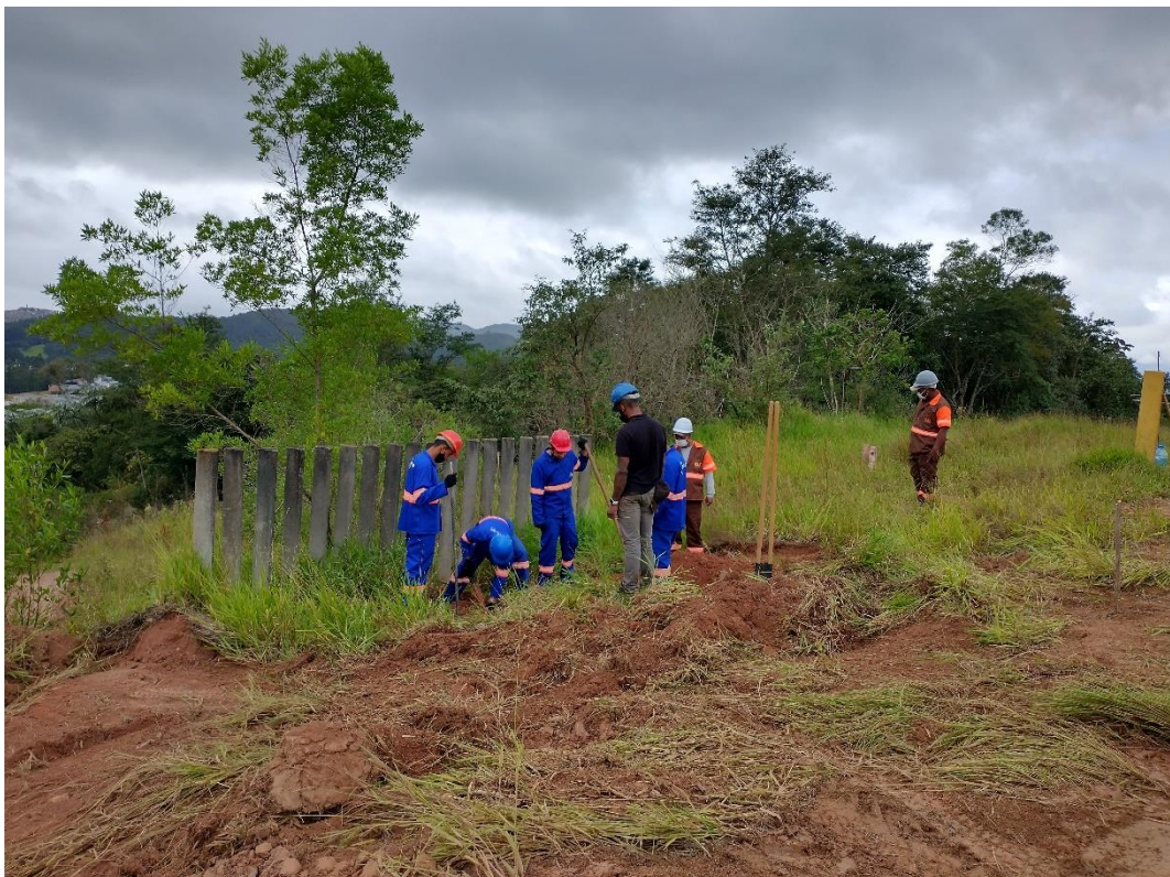
Sondagens manuais na Faixa de Dutos.
