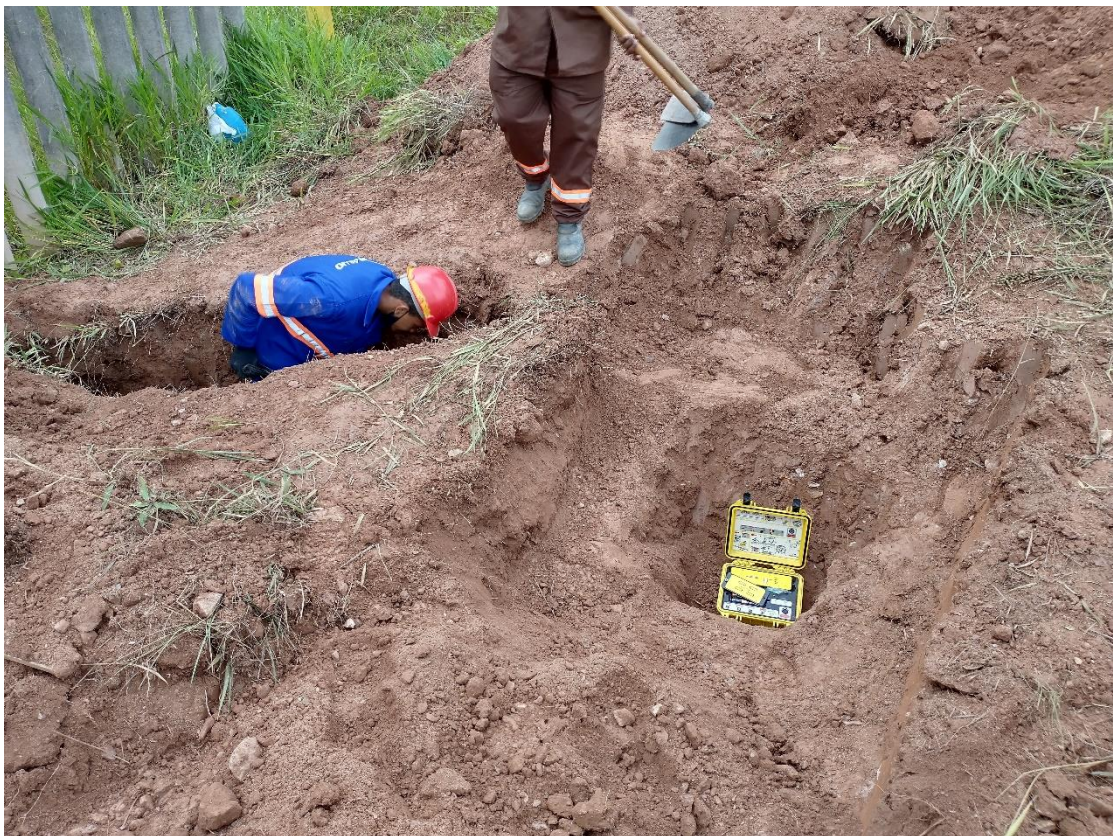
Vala de escavação e sondagens com apoio de equipamentos eletromagnéticos
