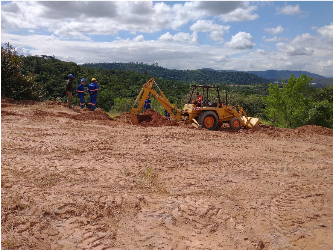
Reaterro dos dutos para evitar a exposição prolongada dos mesmos.
