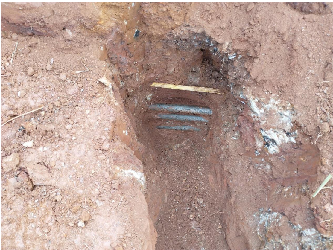
Cabos de Fibra Ótica identificados e cadatrados.
