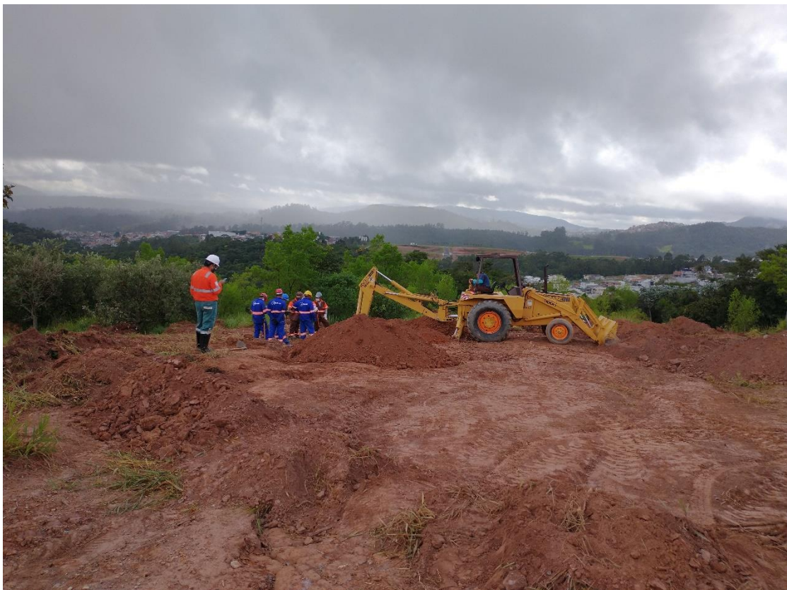
Sondagens manuais com apoio de equipamentos mecânicos com fiscalização da Transpetro.
