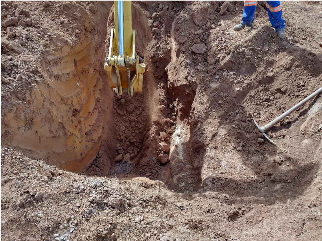
Escavações mecânicas ao lado de um dos dutos.
