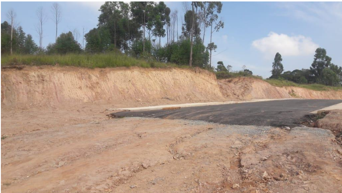
Estrada Itahyê – próxima do limite da Faixa de Dutos.
