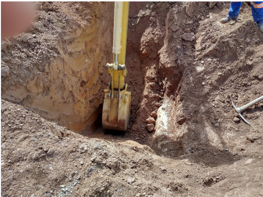
Sequência da escavação para completa exposição do duto.
