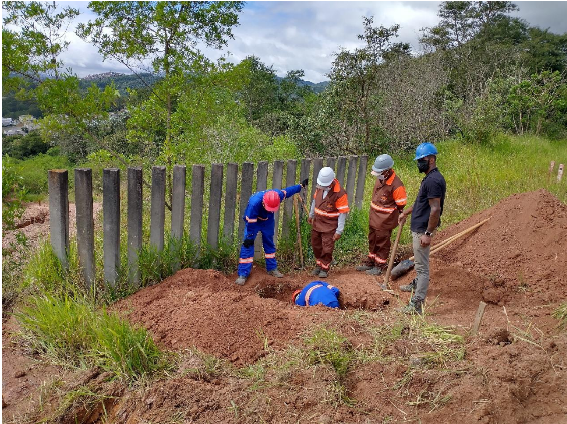
Valas de sondagens manuais que precedem as escavações com equipamentos.
