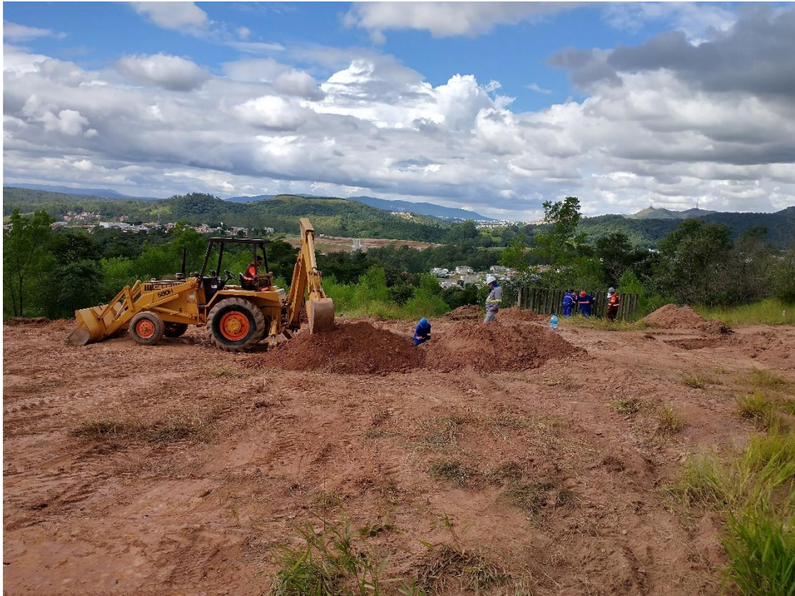
Sondagens manuais com apoio de equipamentos mecânicos.
