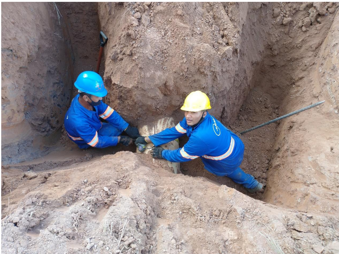
Verificação do revestimento e medição do diâmetro.
